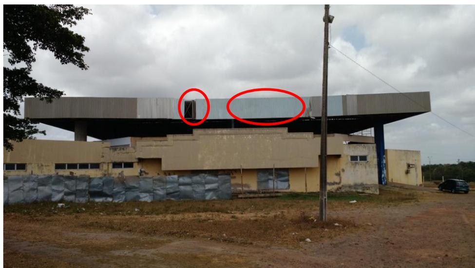
Figura 2 – Descolamento e falta de telhas por vista frontal
