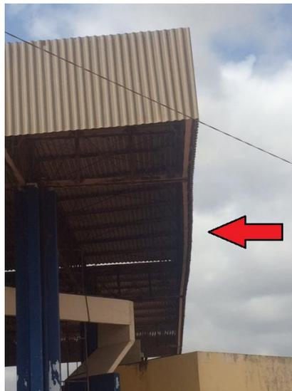
Figura 6 – Desalinhamento do perímetro da cobertura (parte lateral)
