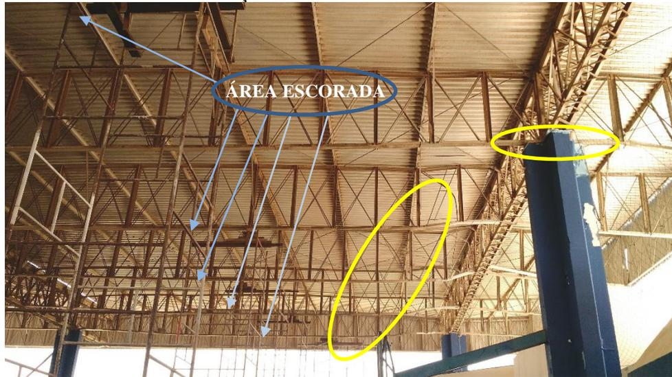
Figura 9 – Estrutura escorada para evitar desmoronamento do vigaumento
