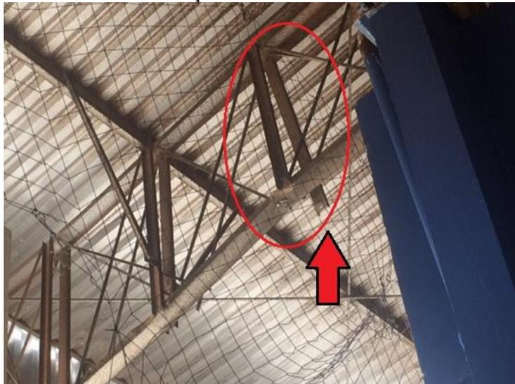
Figura 11 – Montante sem ligação com o banzo inferior
