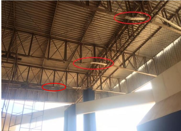
Figura 7 – Detalhe indicando as emendas das barras e deformações próximas
