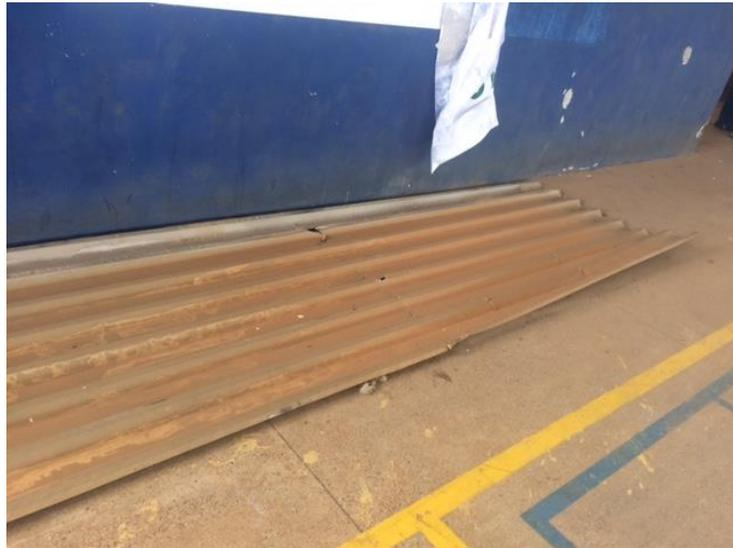
Figura 3 – Parte de telha que se desprendeu da estrutura
