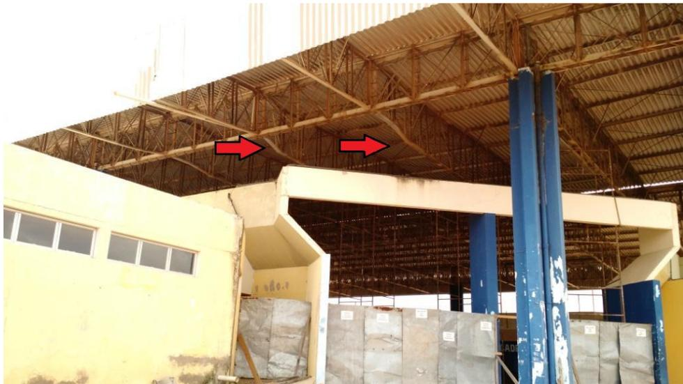
Figura 8 – Banzo inferior da treliça deformado
