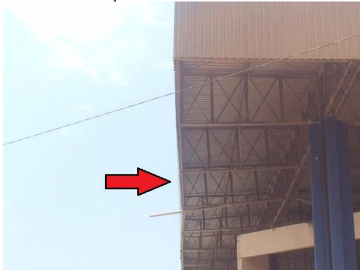
Figura 5 – Desalinhamento do perímetro da cobertura (parte frontal)
